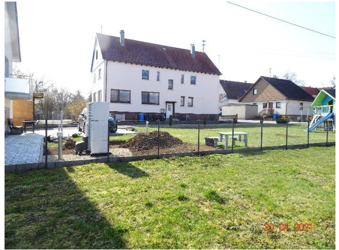
Foto 6: Südlich angrenzende Wohnbebauung (20.04.2021)
