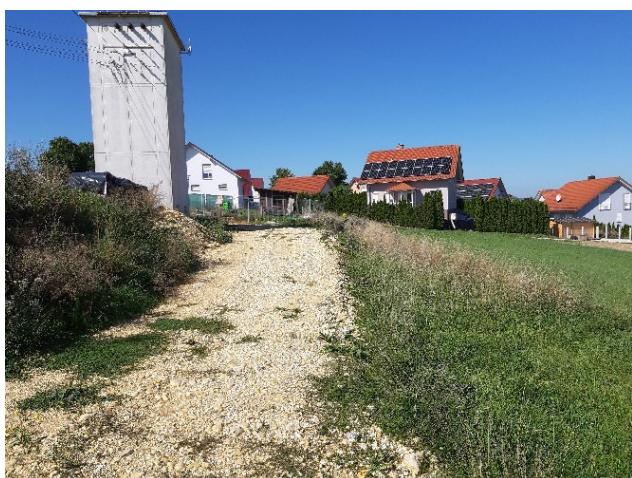
Foto 3: Blick nach Südwesten auf die Trafostation
